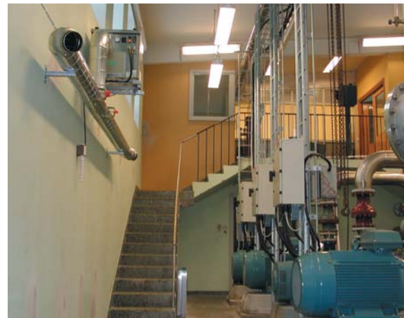
DR-031C kuivain asennettuna vesilaitokseen Ruotsissa.
